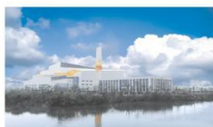
浙江绍兴垃圾焚烧热电联产项目 (2250吨/天)
