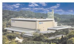
重庆丰盛环保发电厂 (2400吨/天)
