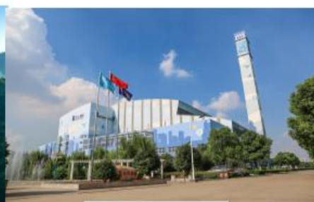
常州垃圾发电项目
