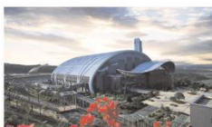
广西南宁环保发电厂 (2000吨/天)
